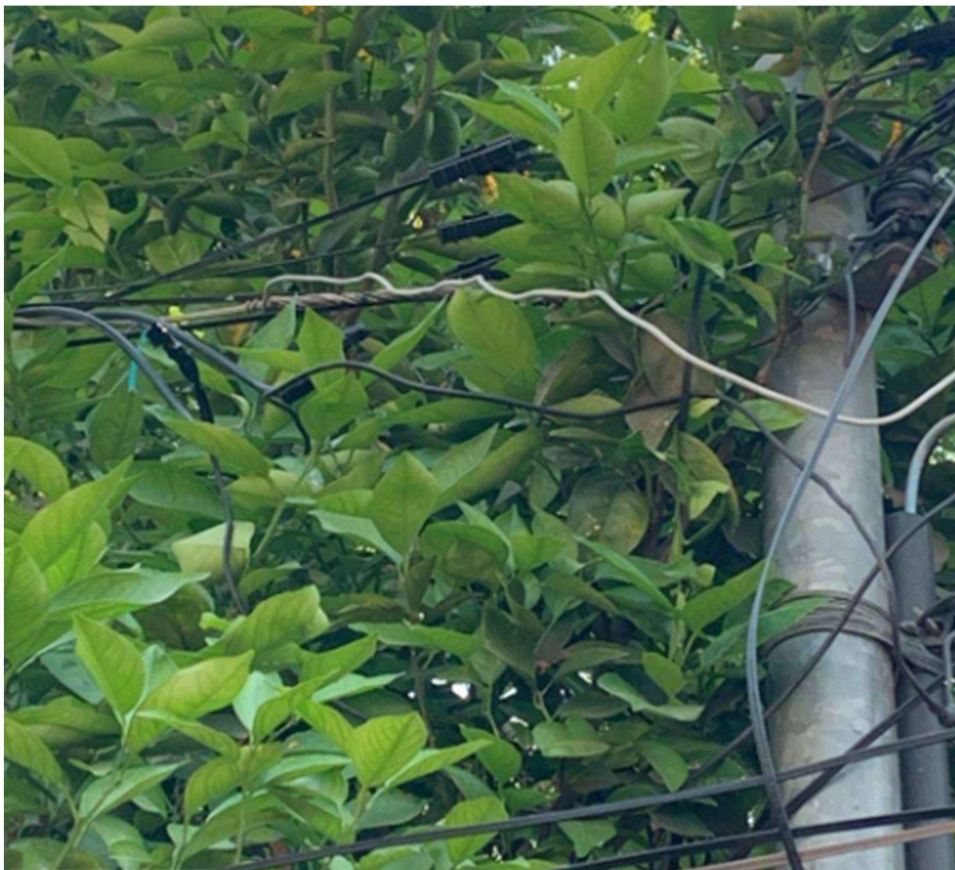
Figura 09 – Exemplo de irregularidade identificada no pingadouro
